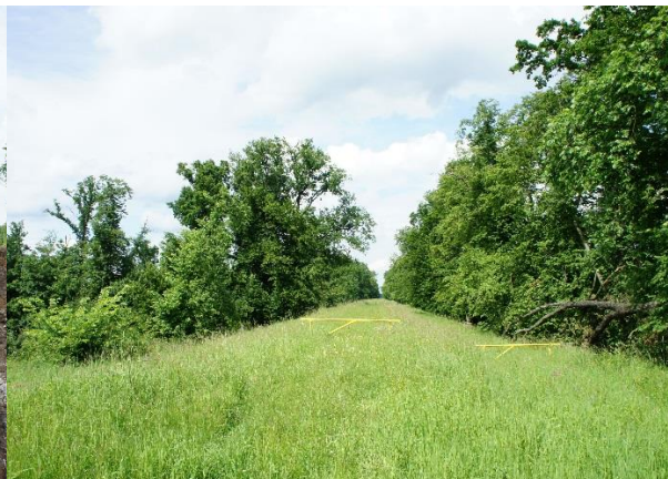
Rys. 2: Stary wał przeciwpowodziowy
