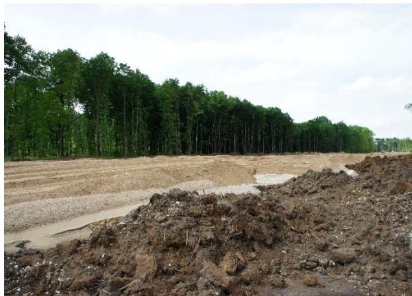
Rys. 1: Budowa nowego wału, czerwiec 2014 r.
